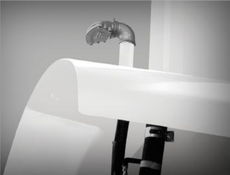
ESPARGIDOR DIRECIONADO PARA CABINE
